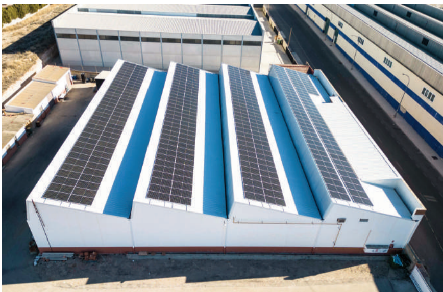
Fundiciones Blas Diaz Martínez, S.L. / 153,44 kWp / Ibi
